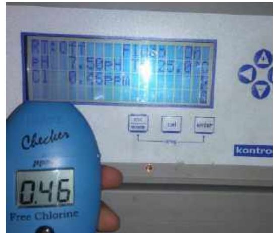
Figura 11.13. Dosificador de cloro
