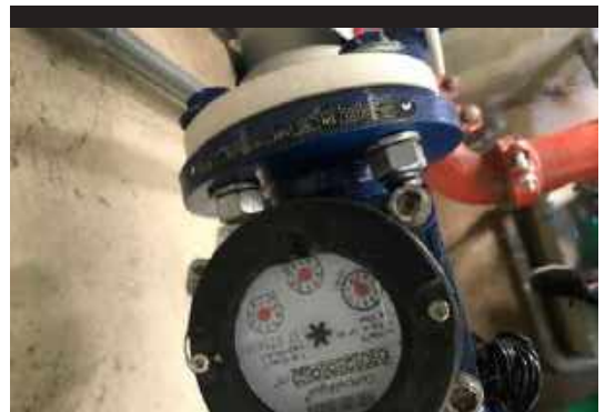
Figura 11.14. Medidor de consumo de agua potable
